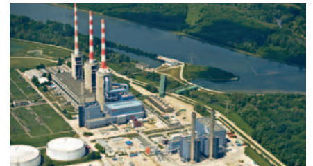
Gas- und Dampfkraftwerk
