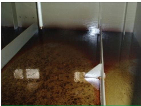
Lack- und Schlammrückstände aus Systemleitungen im Tank einer Gasturbine nach einer Spülung
