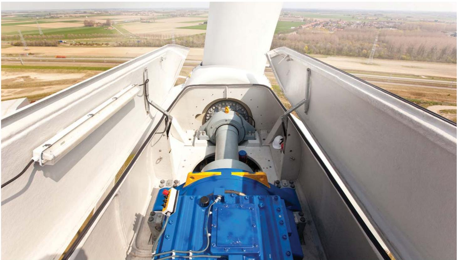
13. Füllen Sie das Getriebe bis zur Mindestmarkierung mit **Mobil Flush 320** für den Ölkreislauf auf. Entnehmen Sie das erforderliche Füllvolumen – üblicherweise ca. 60 % der Getriebekapazität – den Angaben des Windturbinenherstellers.
